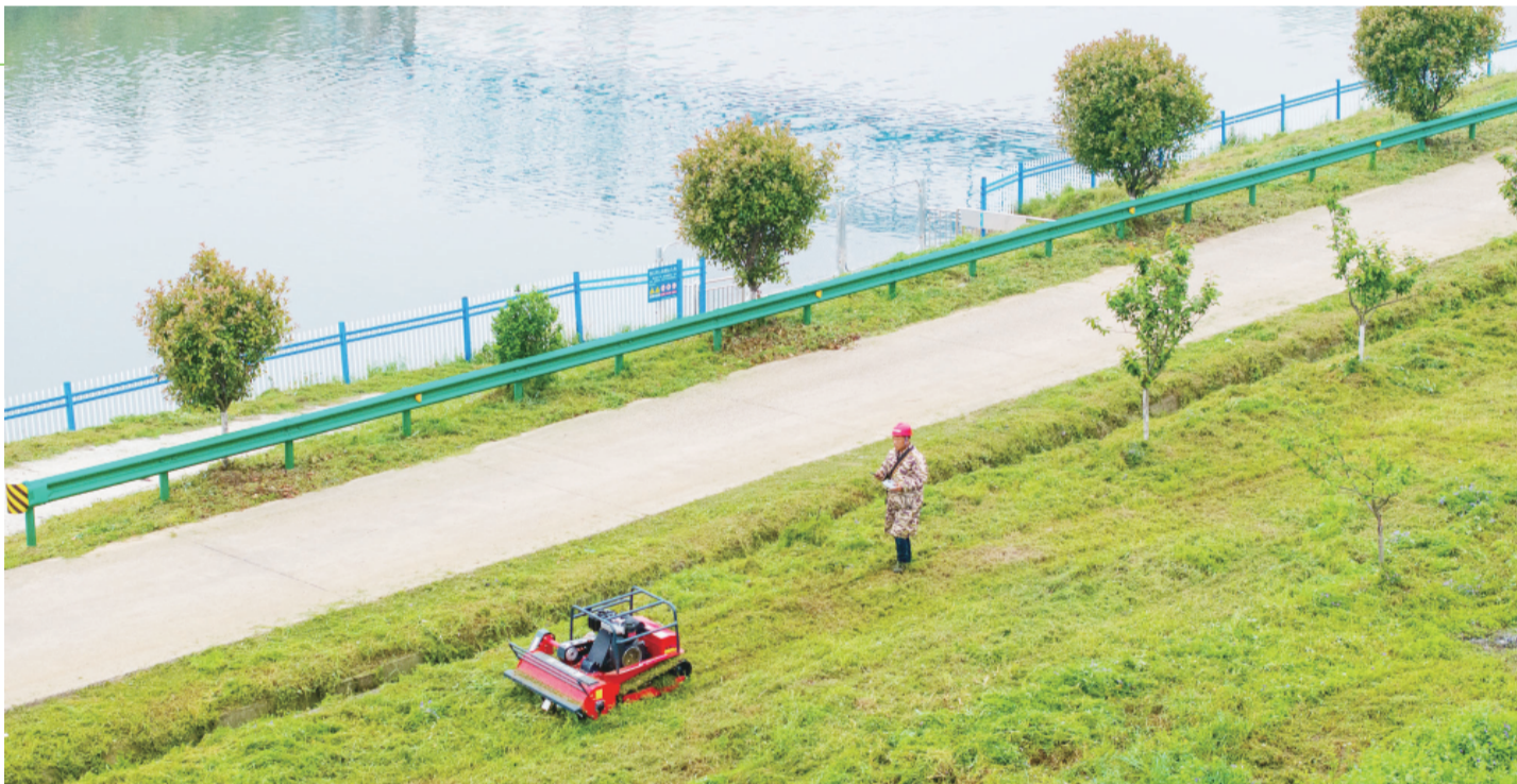
4月21日，淠史杭灌区河河总干渠金安段岸边，工人正操控履带式无人割草机进行除草控高作业。
