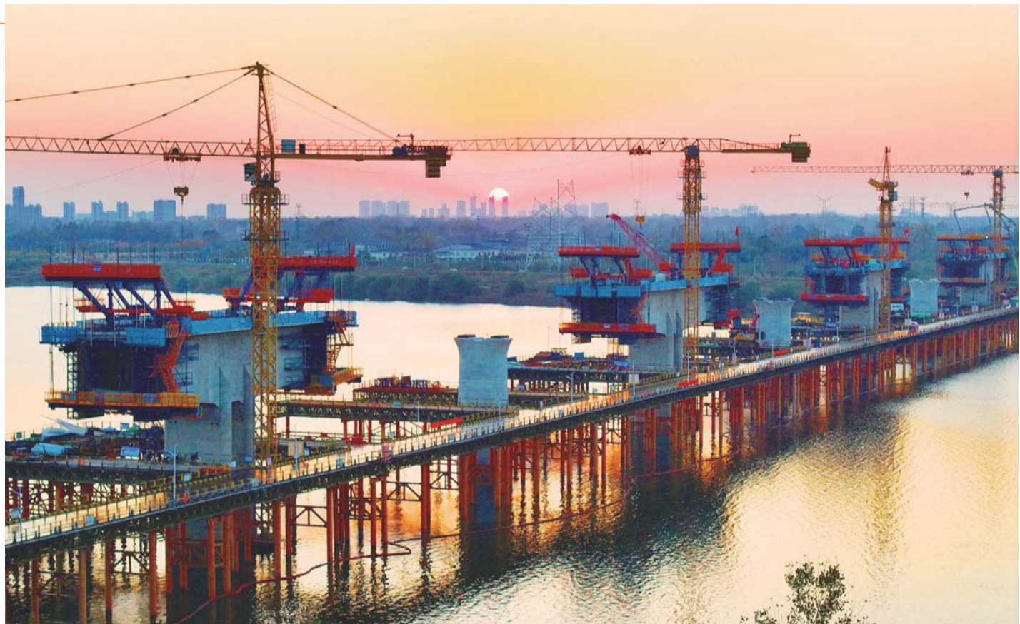
11月11日傍晚,全安城北镇境内,合六高铁六安河特大桥(金裕河特大桥)紧张的施工现场与天边绚丽的晚霞交相辉映,构成一幅壮美的初冬施工画卷。
