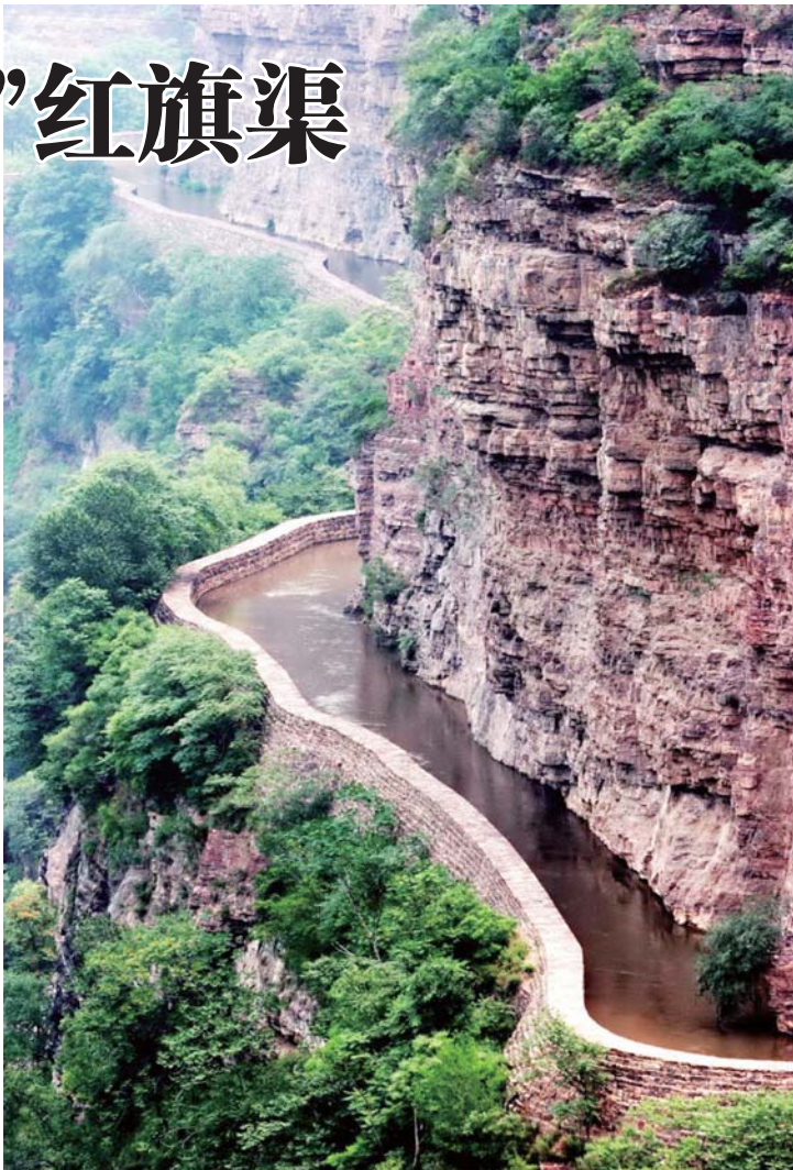
红旗渠，被誉为“人工天河”，曾被称为新中国两个奇迹之一(另一个指南京长江大桥)。红旗渠的修建，是一个漫长过程，经历了从“爱民渠”到“英雄渠”再到“红旗渠”的艰难历程。其最早的源头——“爱民渠”，就是著名的开国中将——皮定均带领军民修建的。
